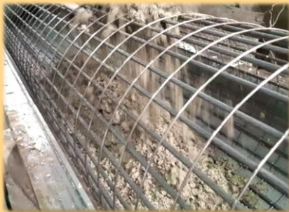
投料 (Concrete placing)
