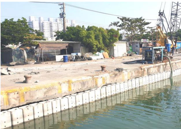
step 3 : 排樁完成
