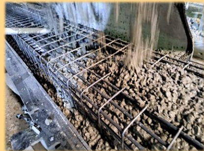
投料 (Concrete placing)
