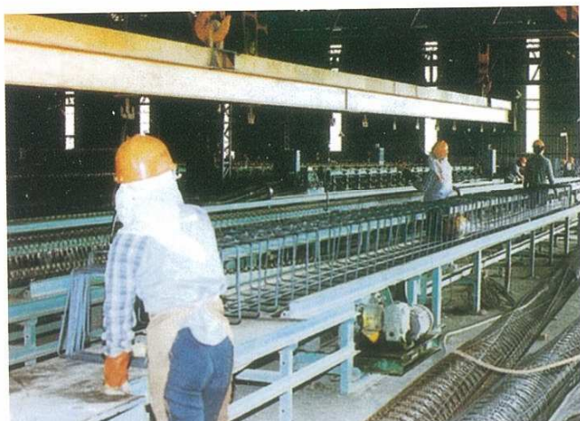
▲ 鋼筋籠編組 STEEL CAGE
