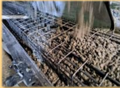
投料 (Concrete placing)
