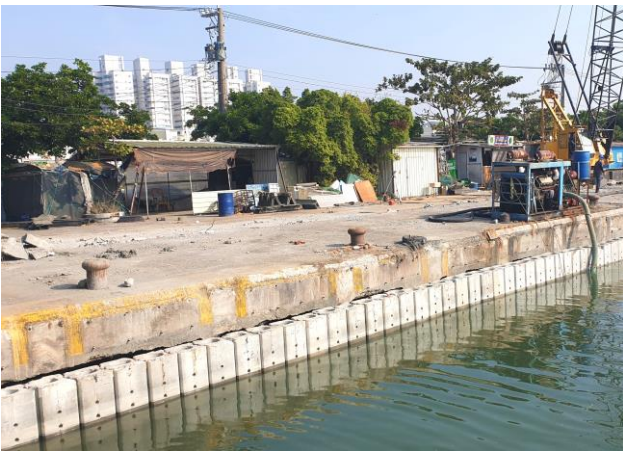
step 3：排樁完成
