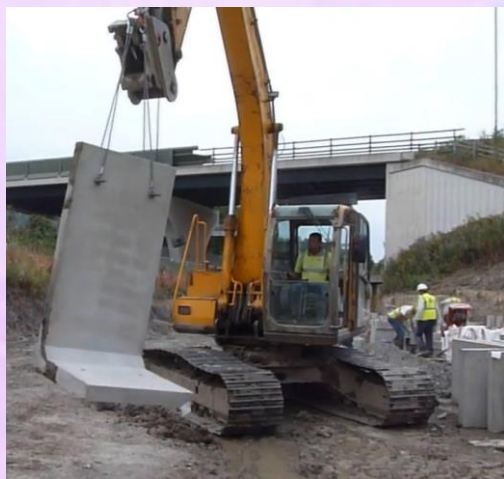
挖土機具吊掛
