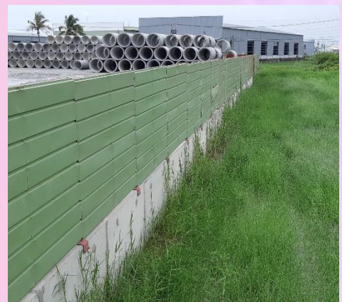
頂端架設防護牆
