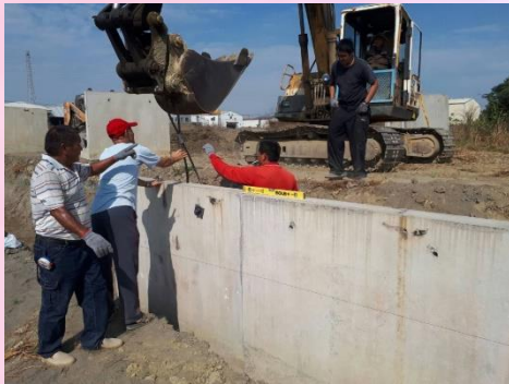
挖土機具吊掛擋土牆
