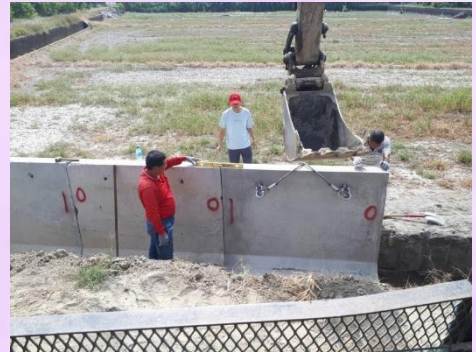
確認擋土牆安裝確實
