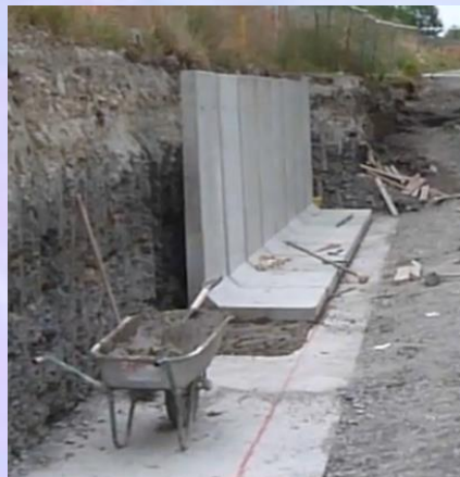
基礎鋪上水泥沙漿
